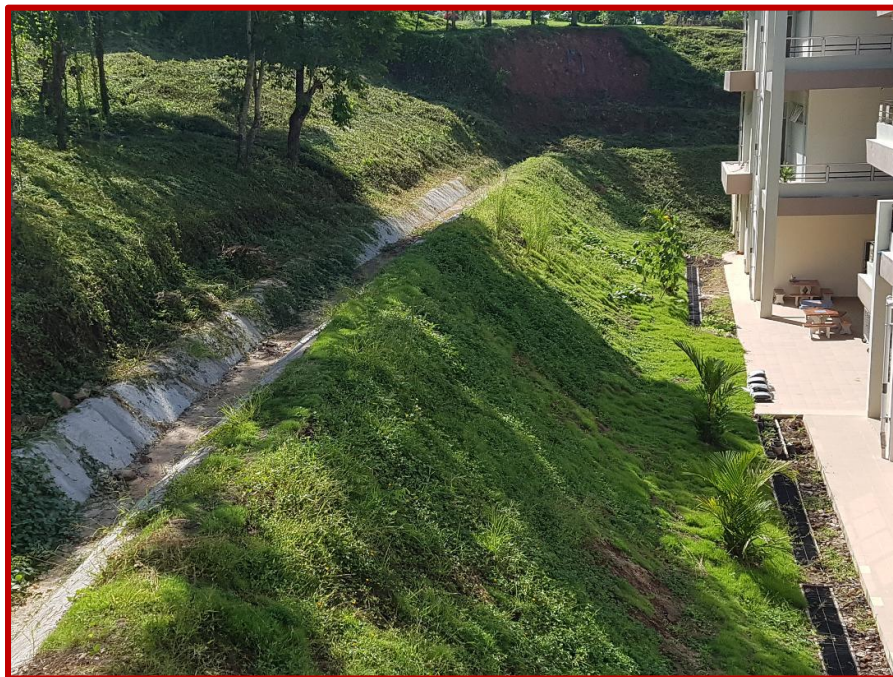
ภาพ...การจัดทำรางระบายน้ำรอบตัวอาคารเพื่อป้องกันน้ำท่วมตัวอาคาร
