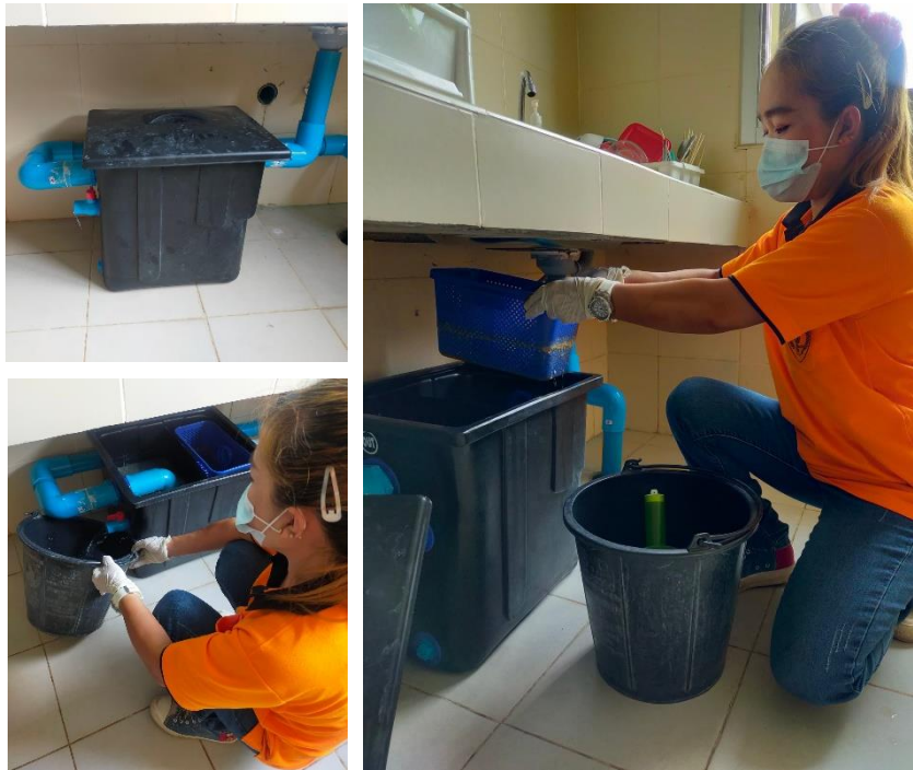
ภาพแสดงการทำทำความสะอาดถังดักไขมัน
